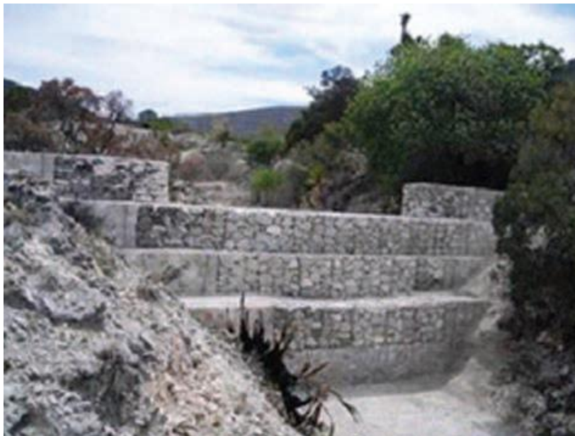
Figura 6. Presas filtrantes de gaviones.
